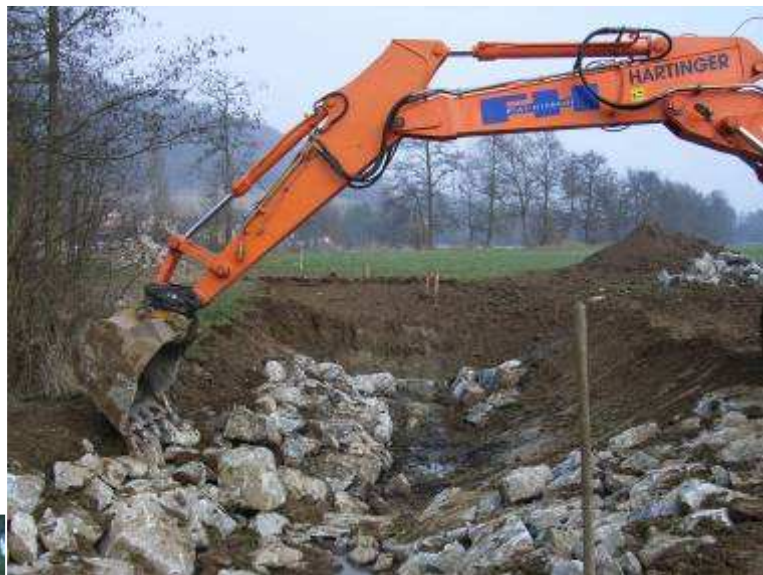
Beginn der Aushubarbeiten und Befestigung mit Wasserbausteinen
