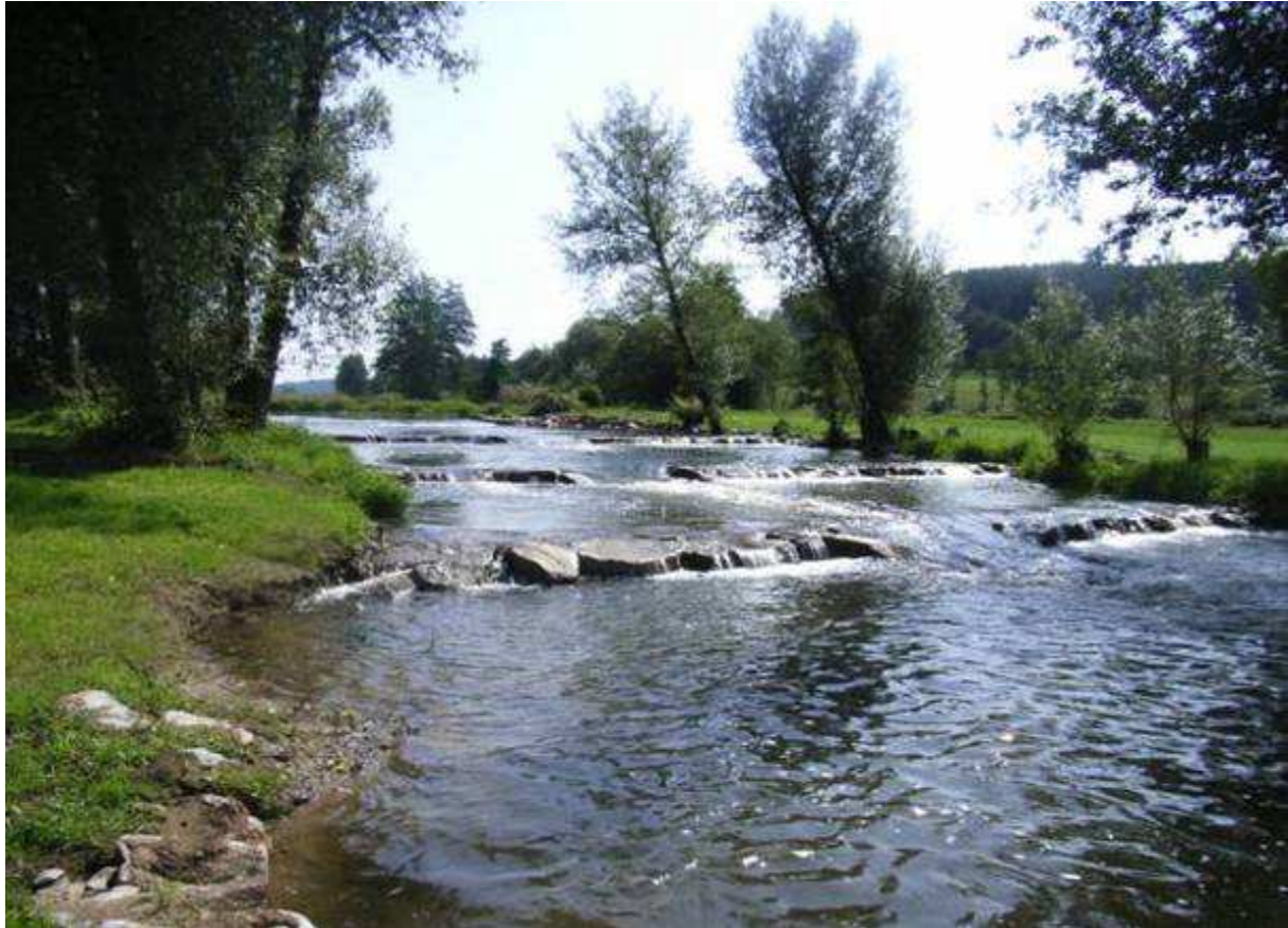
Querriegelbauweise Wehrrumbau Pretzabruck
